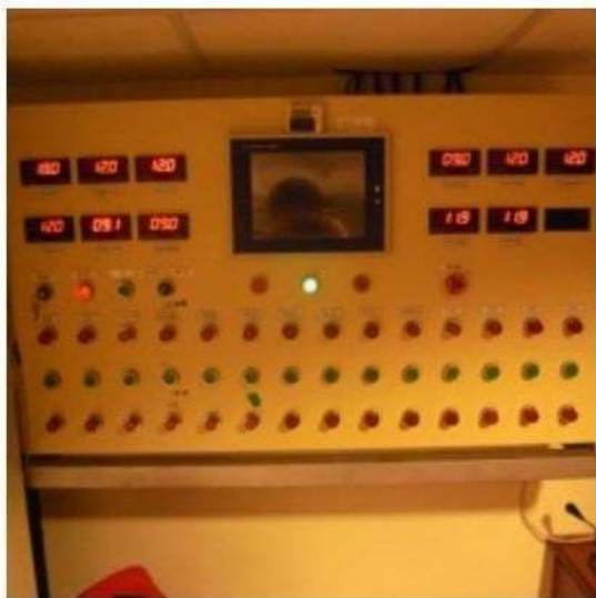
控制室懸吊系統控制面板
